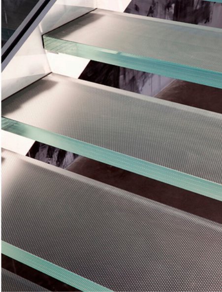
Peldaños en Vidrio Laminado Templado con antiselizante.
