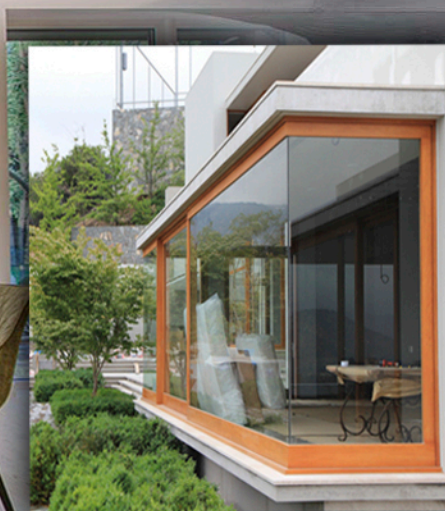
Protección antirrobo laminado 6+6.6
